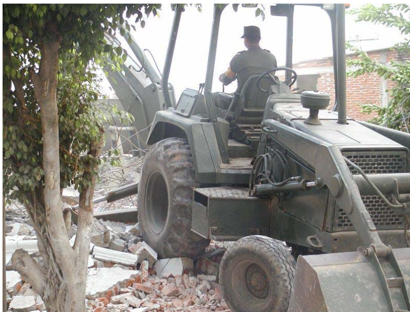
Figura 12 Personal militar en operaciones de demolición
