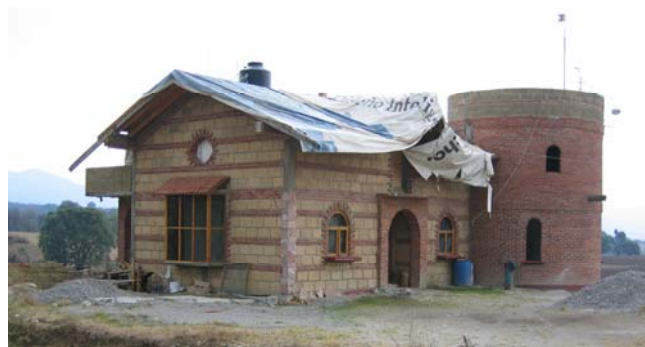
Figura 5. Mampostería combinada con adobe estabilizado y ladrillo rojo recocido
