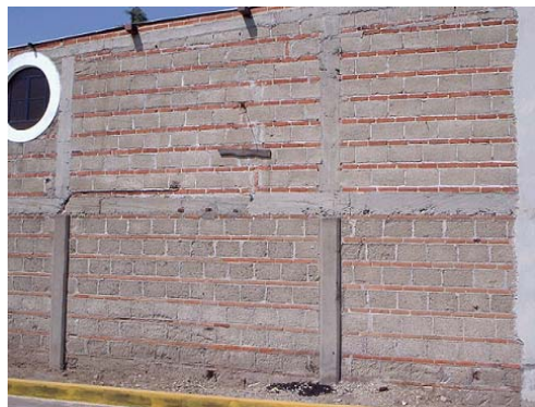
a) Una hilada de bloque por una de ladrillo
