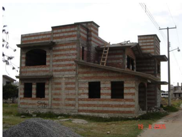
Figura 1. Mampostería combinada y confinada
