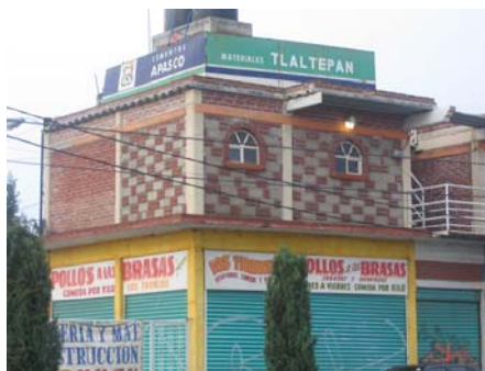
Figura 4. Mampostería combinada en arreglo “coursed Ashlar”
