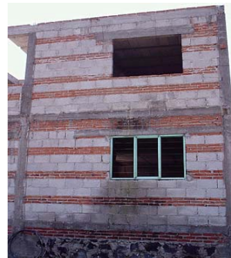
b) Dos hiladas de bloque por tres de ladrillo
