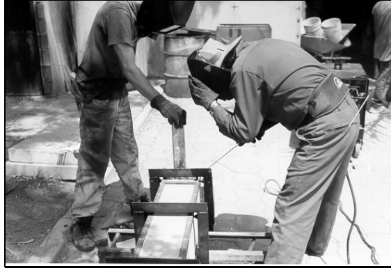
Figura 5. Procedimiento de soldado de las soleras precalentadas
